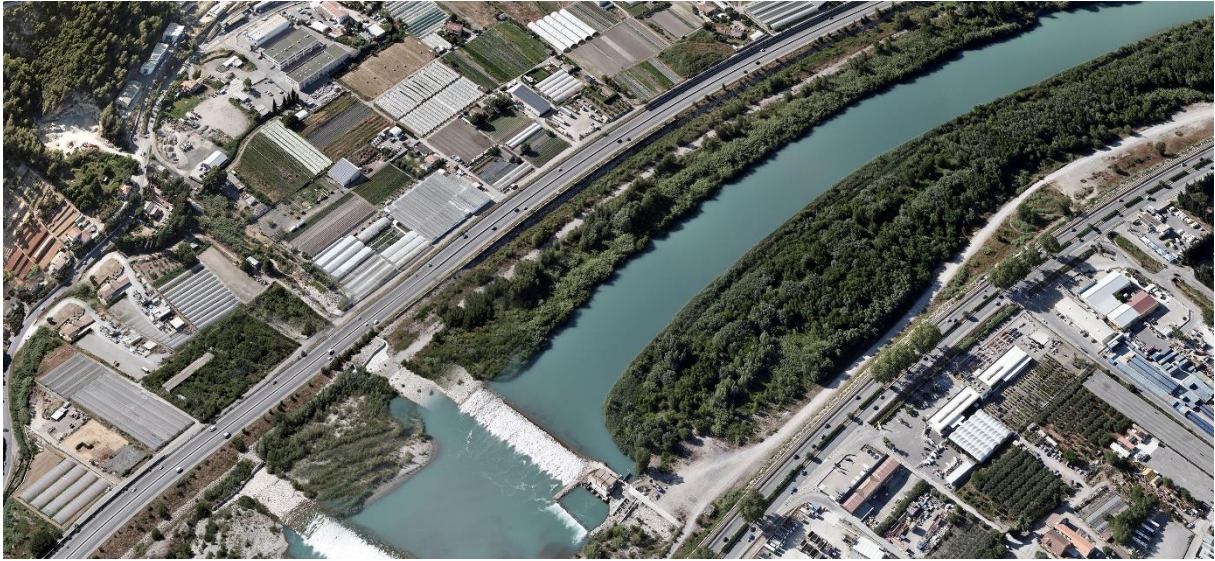
Photo 1 : RM6202 bis à hauteur de St Jeannet et RM6202 à hauteur de la ZA Les Combes
