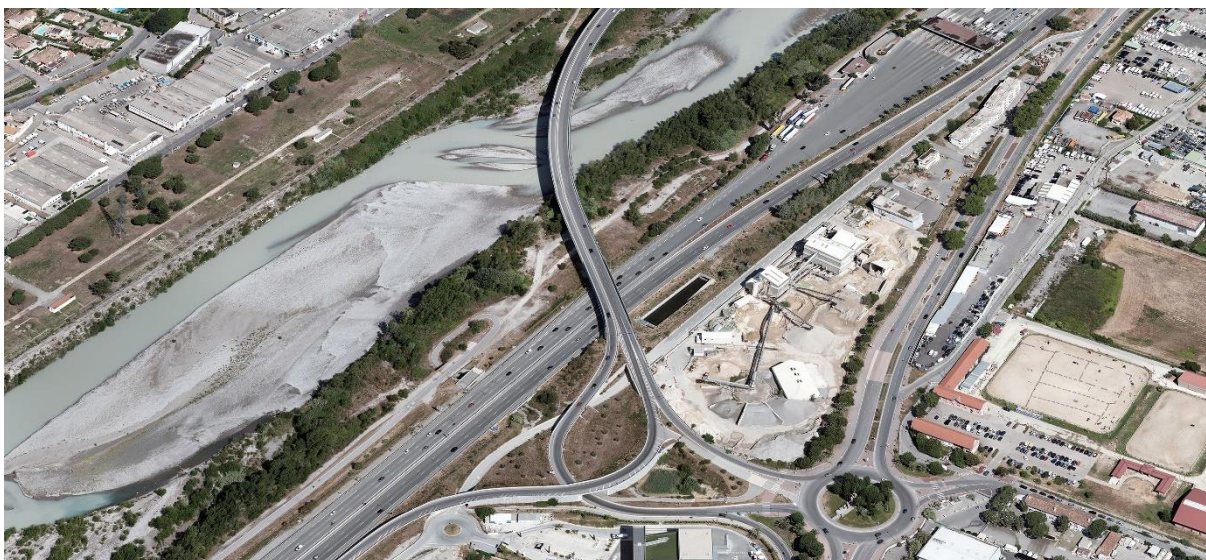
Photo 3 : RM6202 bis à hauteur du franchissement du Var et RM6202 à hauteur du Rond-Point des Baraques
